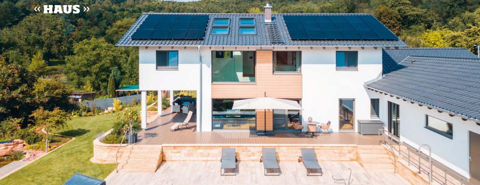
⚡ **Effizient:** Auf den Dachflächen des Haupthauses findet beidseitig Solarausbeute statt – die riesige Photovoltaikanlage versorgt das Gebäude, ein Stromspeicher hält Strom für die Abend- und Nachtstunden vor. 🏠 **Verbunden:** Mehr oder weniger unter einem Dach wurden bei diesem von einem Architekten geplanten Haus in Fertigbauweise das Hauptgebäude, eine Einliegerwohnung und eine Garage samt Carport vereint.
