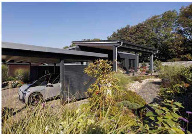
Das Ensemble besteht aus dem Bungalow, dem Terrassendach mit Photovoltaik und dem Carport mit Müll- und Ladestation.
