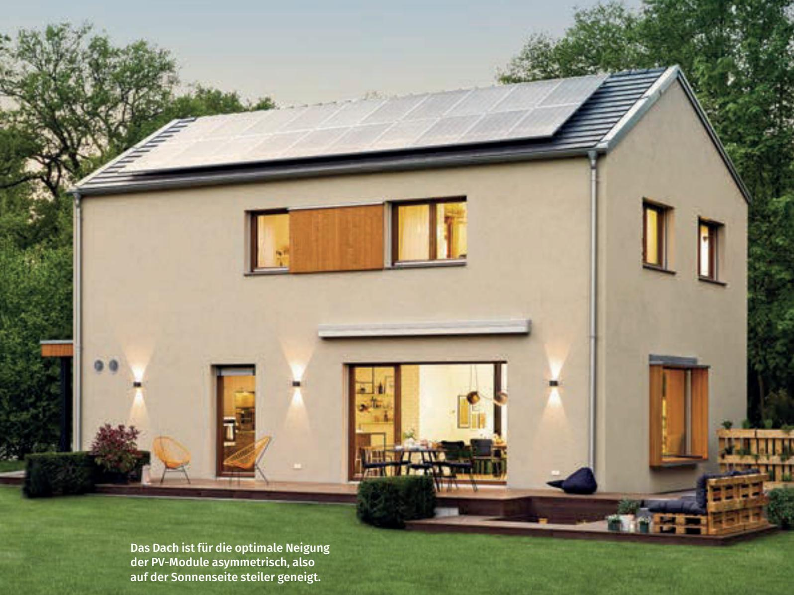
Das Dach ist für die optimale Neigung der PV-Module asymmetrisch, also auf der Sonnenseite steiler geneigt.
